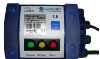
Abb. 62 Gaswarngerät Warneinheit
