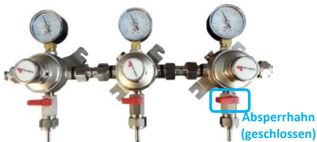
Abb. 79 Zwischendruckregler
